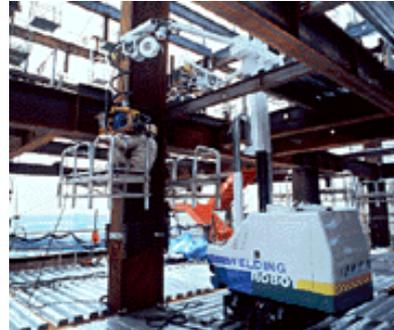
Soldadura de armazones metálicos
